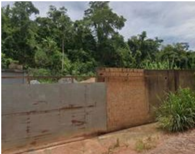
Imóvel da antiga lavanderia do HAG fica por sobre a canalização do Córrego da Estiva (crédito da foto: divulgação da CMPN)
