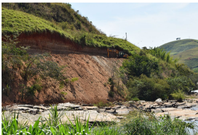
Máquina trabalha na construção de estrada, por onde passarão interceptores de esgoto para acesso à futura ETE-Ponte Nova (crédito da foto: Ronaldo Fernandes/Comunicação e divulgação da CMPN)
