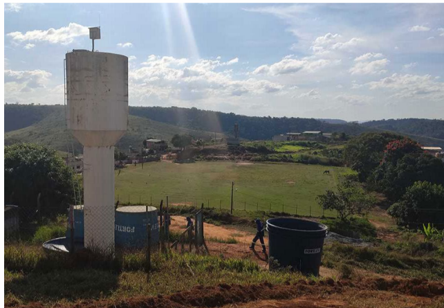
Reservatório de Água no Distrito Vau Açu é o responsável pela distribuição para as residências (crédito da foto: divulgação DMAES)
