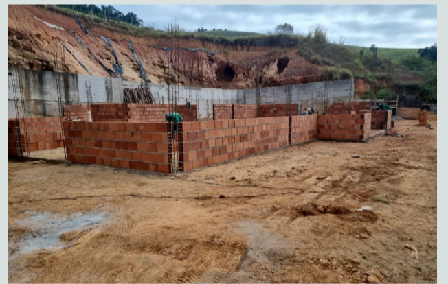
A obra da UBS no Vale do Ipê atenderá moradores do Bairro Santo Antônio (crédito da foto: divulgação da AsCom da PMPN)
