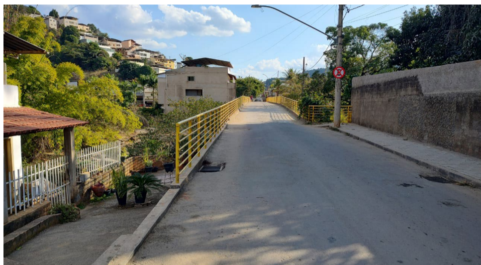
A ponte que liga a região da Central ao Bairro Copacabana pode receber asfalto e cancela, depois de 02 (dois) anos. Não há previsão de calçada para pedestres (crédito da foto: Diego Siman/Líder Notícias)
