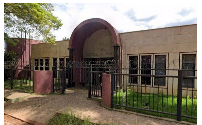
Sede da Justiça do Trabalho em Ponte Nova, ao lado da Rodoviária Nova, no CDI (crédito da foto: divulgação do TRT-MG)
