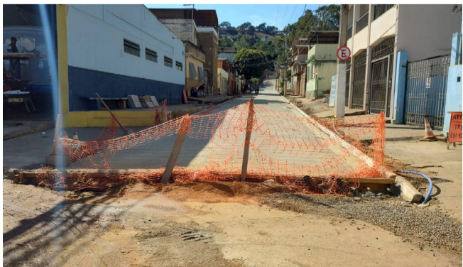
Atual estágio da obra de concretagem na Vila Oliveira (crédito da foto: Diego Siman/Líder Notícias)
