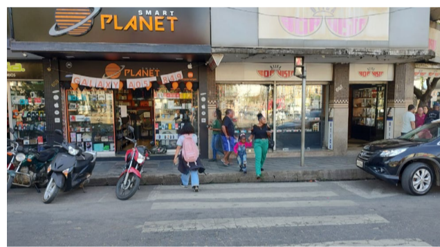
● Na Avenida Francisco Vieira Martins, principal via de Palmeiras, na esquina com Dr. Otávio Soares, não existe rampa de acessibilidade em um passeio fora da ABNT (crédito da foto: Diego Siman/Líder Notícias)
