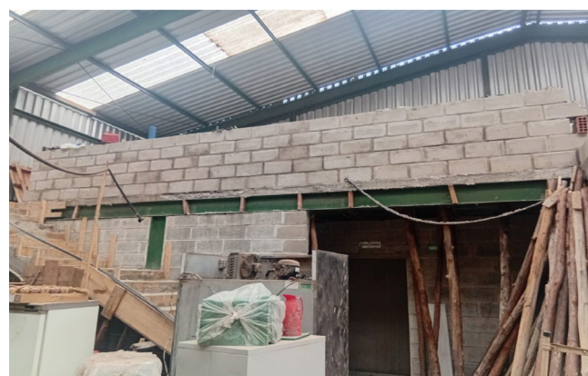
Cozinha conjugada está em construção do Galpão de Triagem da Coorpnova (crédito da foto: Ricardo Motta/Líder Notícias)
