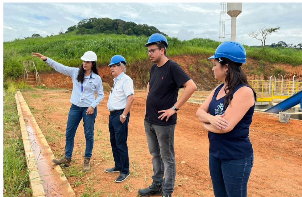
A engenheira civil do DMAES, Ingrid Macedo mostra as obras da ETE ao Diretor-geral do DMAES, Dr. Eduardo Bemfeito (2º à esq.) e à Diretora-adjunta Daniela Pasquolon (à dir.). Ainda na foto aparece Walter Matoso, gerente de contratos da empresa RFJ Construção e Engenharia, responsável pela obra (crédito da foto: Gabriel Chaves)
