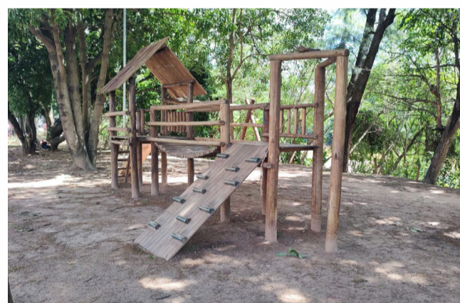
Parquinho infantil instalada na margem direita do Rio Piranga (Avenida Custódio Silva) precisa de manutenção (crédito da foto: Diego Siman/Líder Notícias)
