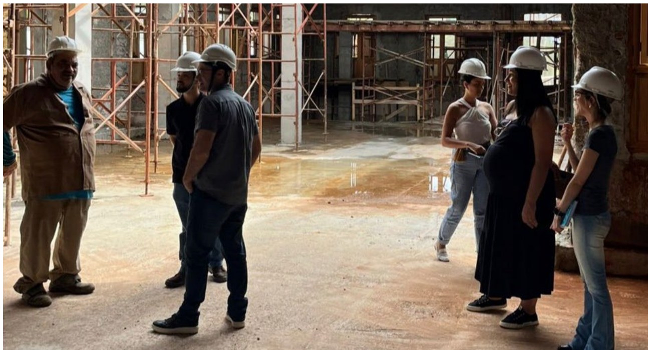
O prefeito Dr. Milton (Avante) visitou as obras do Hotel Glória no dia 10 de janeiro de 2025 (crédito da foto: Departamento de Publicidade do Poder Executivo)
