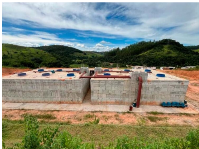
A ETE deverá ser concluída ainda este ano (crédito da foto: Gabriel Chaves/DMAES)
